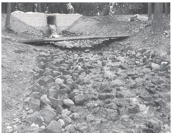
図-5 人工石を用いた排水溝
