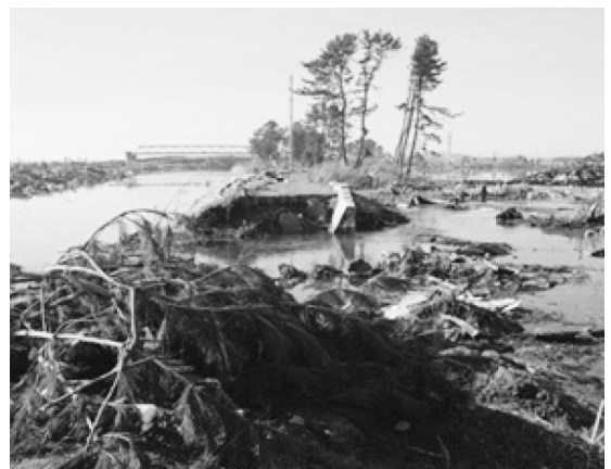
＜破堤した貞山運河（木曳堀）＞
