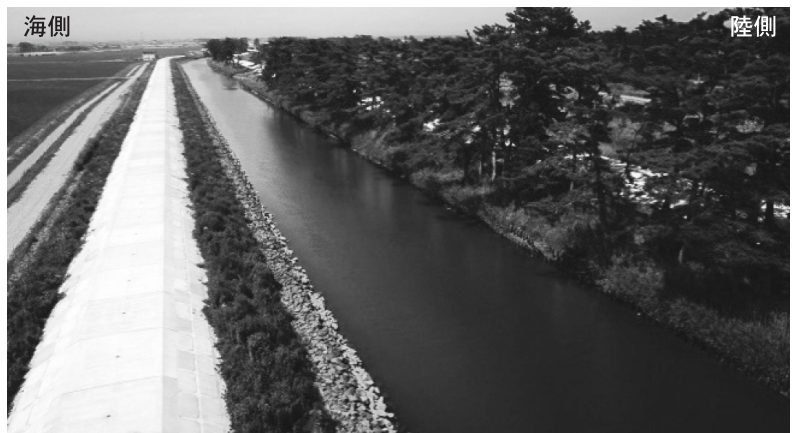
松並木を保存した例（堤防を陸側に配置_写真右）
